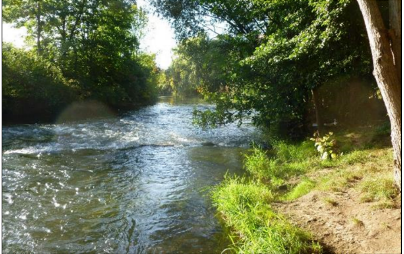
Abb. 24 Sohlschwelle am östlichen Ende von PS 2_F (Foto: R. Bäumler)
