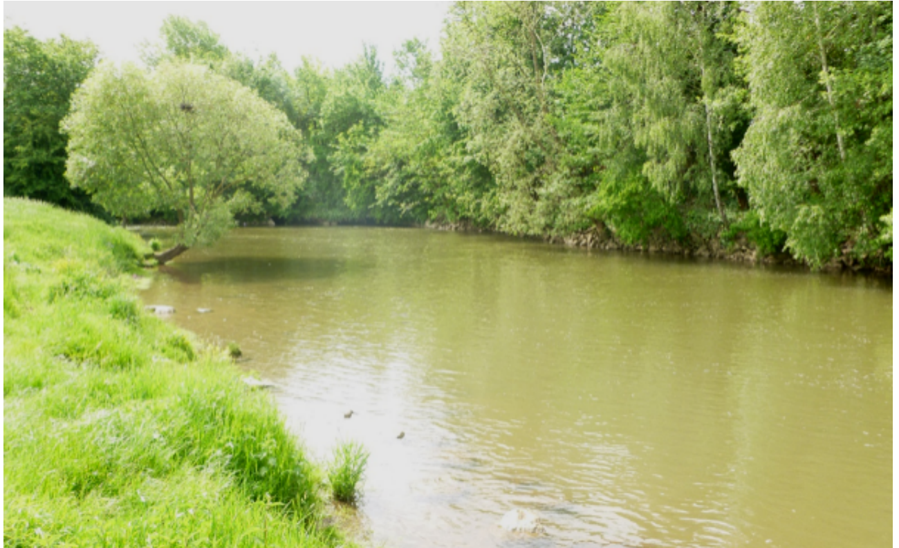
Abb. 46: Empfehlung: Entfernung der Versteinung (Blocksteinschüttung) bei PS 1_F, Einbringen von Störsteinen, Totholzbuhnen und generell Totholz als strömungslenkende Maßnahmen (Foto: R. Bäumlner).
