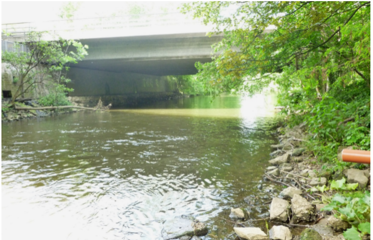
Abb. 51: Empfehlung bei PS 4_F (Beginn der Probestrecke): Entfernung der Versteinung, Anlegen von Totholzbunnen zur Erhöhung der Strömungsgeschwindigkeit, Einbringung von Störsteinen, Auflockerung von Kies (Foto: R. Bäumlner)
