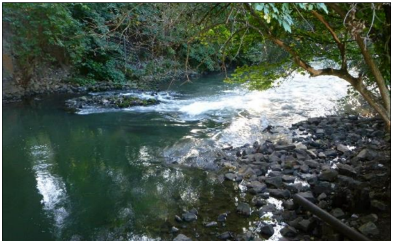
Abb. 22: Raue Rampe am westlichen Ende von PS 1_F (Foto: R. Bäumler)
