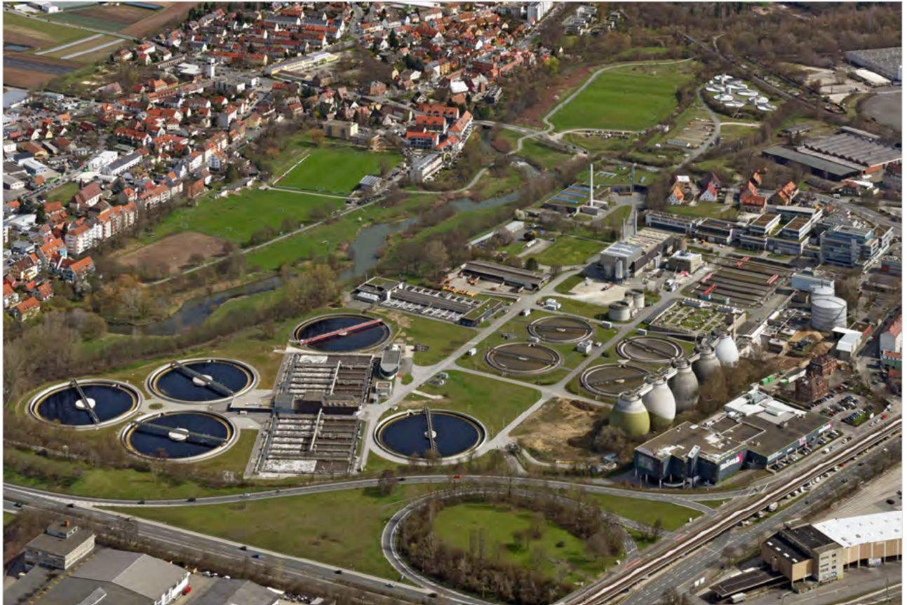
Abb. 1: Luftbild des Klärwerks 1 (früher „Kläranlage Nord“); Foto Hajo Dietz
