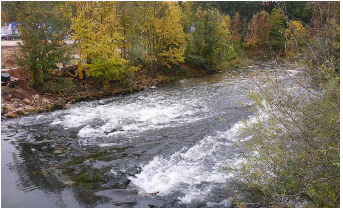
Abb. 49: Raue Rampe bei PS 3_F (nicht durchgängig) mit Baustelle für Surferwelle im Hintergrund des linken Ufers im Oktober 2020. Empfehlung: Umbau in Pendelrampe und Verbesserung des Laichhabitats durch Anlegen eines Kieslaichplatzes in der Strömungsmitte vor dem Prallufer; Einbringen von Störsteinen als Ausgleichsmaßnahme für Surferwelle.
