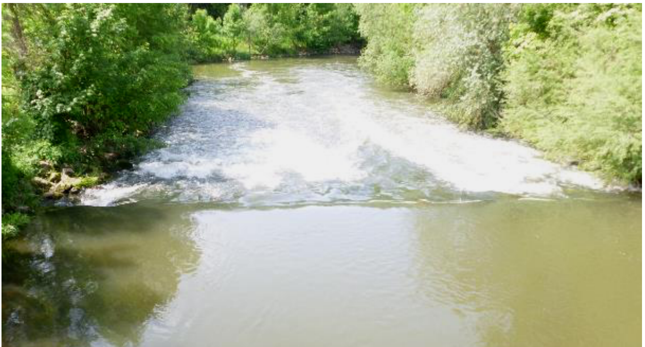
Abb. 27: Raue Rampe am Ende der Probestrecke PS 3_F. Im Nebenschluss entsteht hier eine Surferwelle (Foto: R. Bäumlner)
