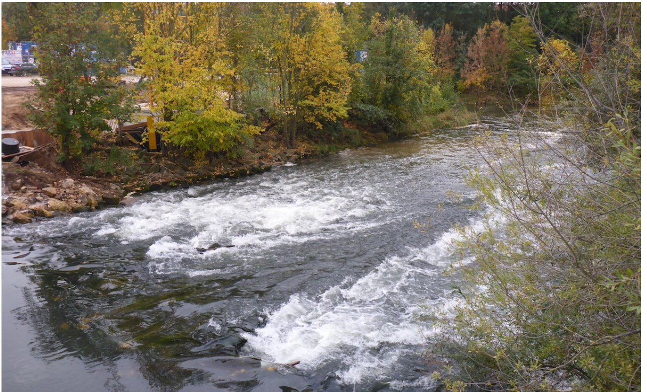
Abb. 33: Raue Rampe bei PS 3_F (nicht durchgängig) mit Baustelle für Surferwelle im Hintergrund des linken Ufers im Oktober 2020. Empfehlung: Umbau in Pendelrampe und Verbesserung des Laichhabitats durch Anlegen eines Kieslaichplatzes in der Strömungsmitte vor dem Prallufer; Einbringen von Störsteinen als Ausgleichsmaßnahme für Surferwelle.
