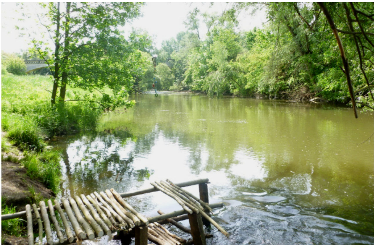
Abb. 31: Stromauf von PS 2_F Einbringung von Störsteinen und Totholzbunnen im Bereich der Sohlgleite, Totholz belassen und strömungslenkende Maßnahmen vor der Sohlgleite (Foto: R. Bäumlner)
